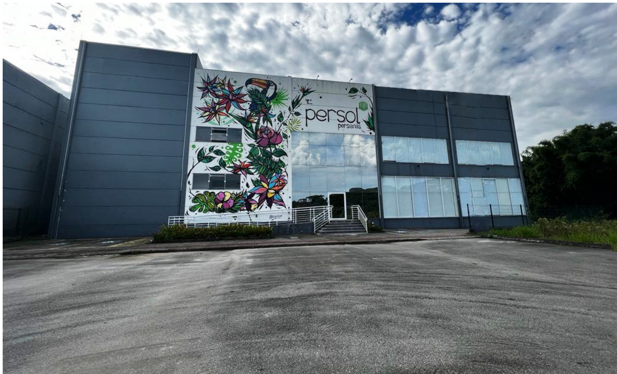
A Persol espalhou-se pelo Brasil, tornando-se a única do segmento com cinco fábricas regionais. Fábrica da Persol em SC, 2020.
