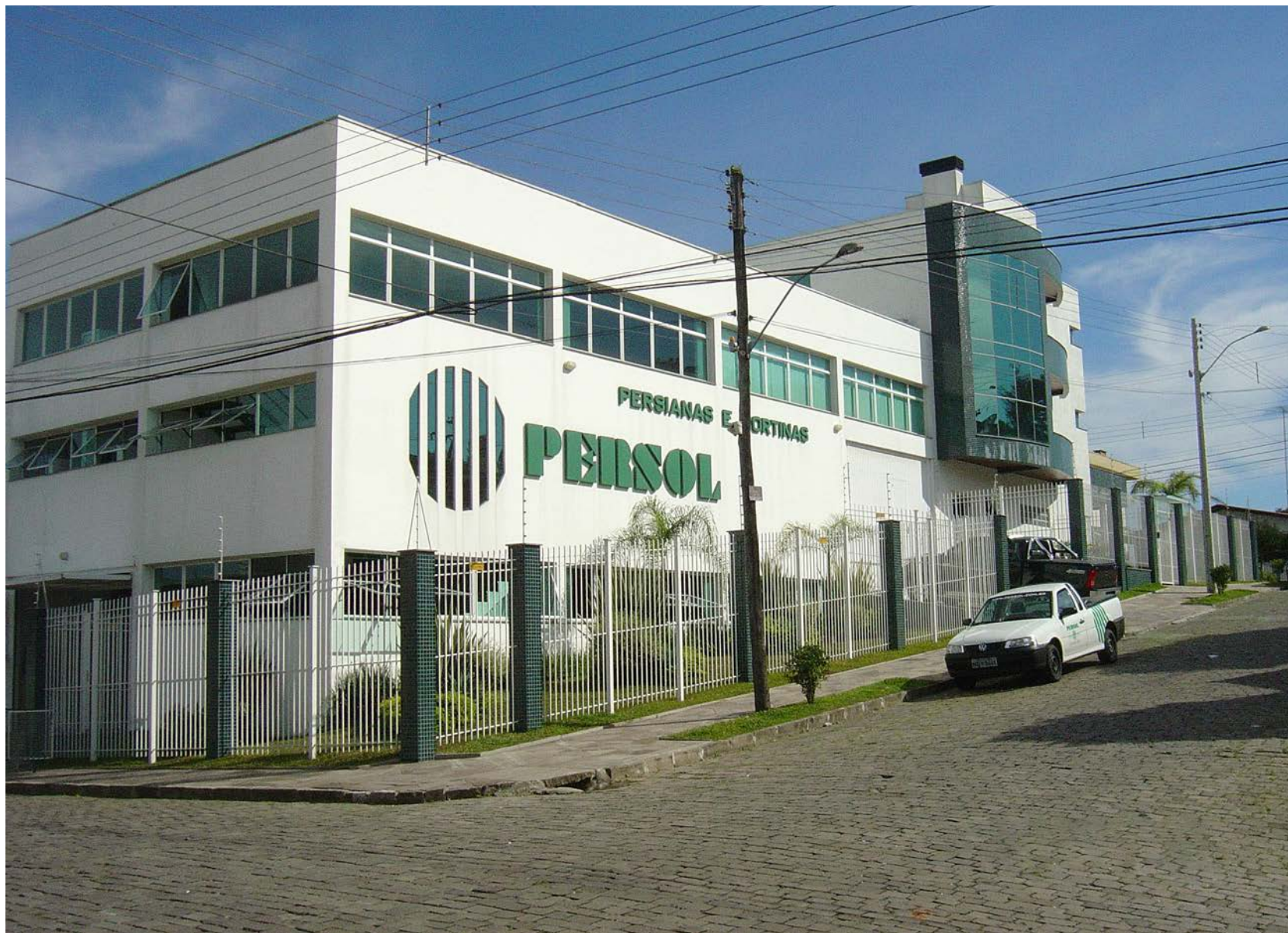
Fachada de Caxias, primeira sede própria.
